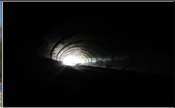
매봉터널 내부 전경(원주방향)
