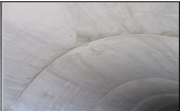
매봉터널 천정부 시공 상태 점검(원주방향)
