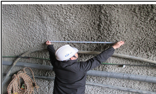
매봉터널 지보패턴간격 측정(원주방향)
