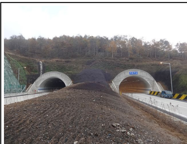
시점측 터널부사면 전경
