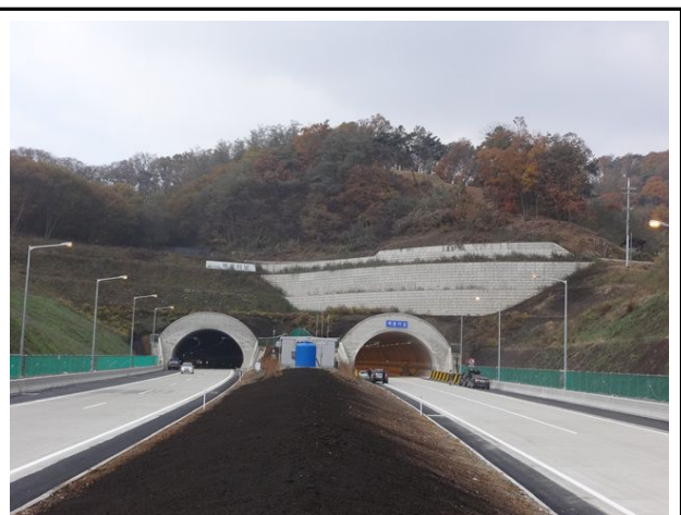
중점측 터널부사면 전경
