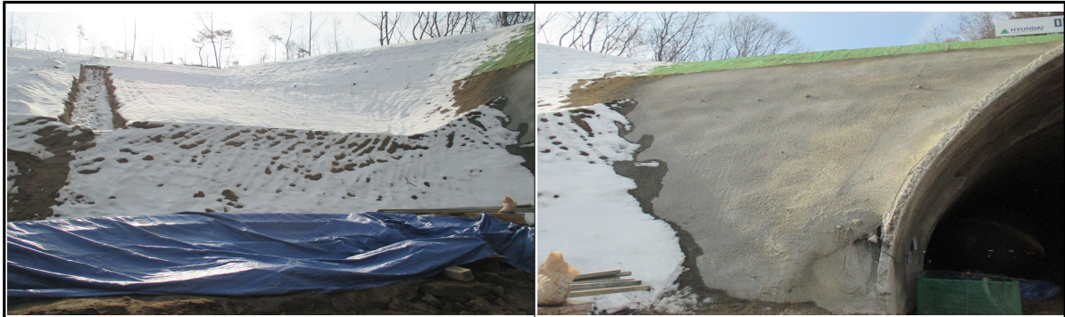
매봉터널 중점부 사면 시공 상태 (원주방향)
