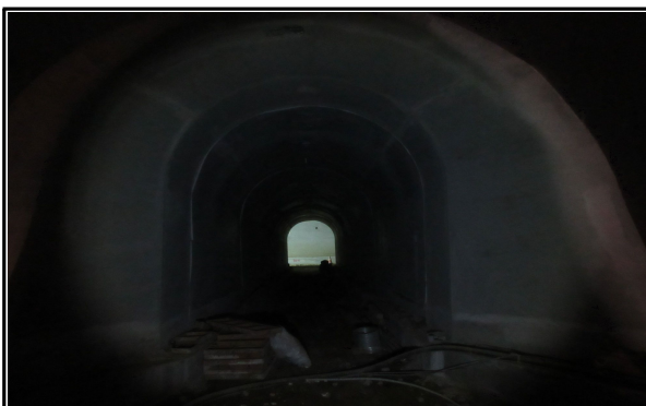
매봉터널 횡갱 전경
