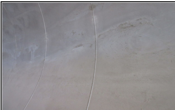
매봉터널 라이닝 시공 상태 점검(원주방향)
