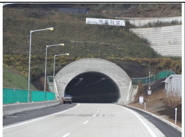
갱문 종점부 전경
