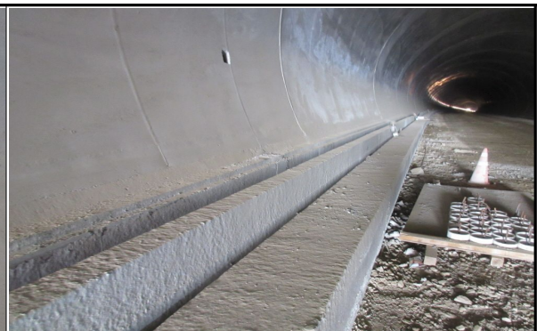
매봉터널 공동구 시공상태 점검(원주방향)
