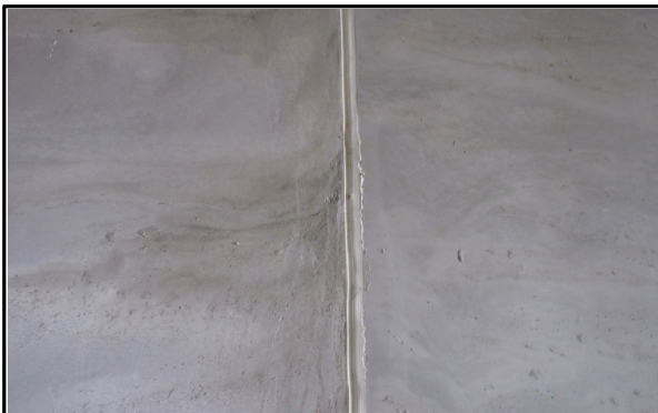
매봉터널 JOINT 시공 상태 점검(원주방향)
