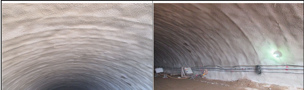
매봉터널 숏크리트 시공 상태(원주방향)
