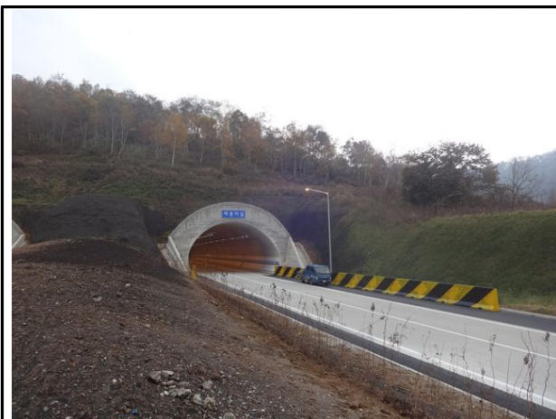
갱문 시점부 전경
