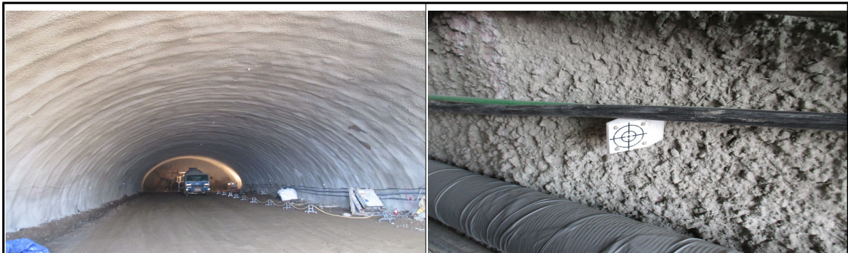
매봉터널 내부 전경(원주방향)
